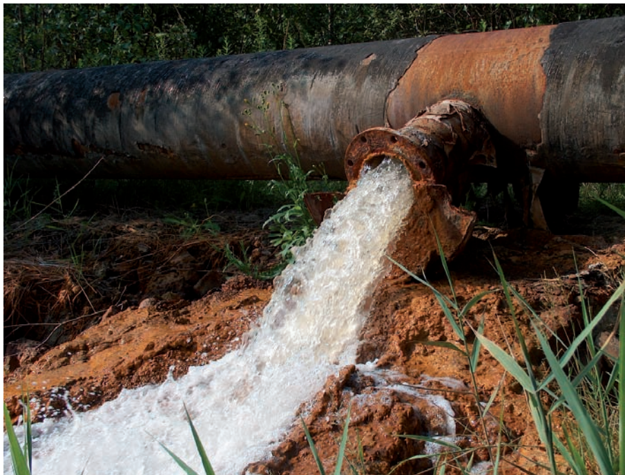
Rys. 2. Miejsce odprowadzania wody ze zlikwidowanej kopalni „Pstrowski”
